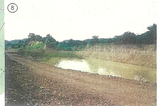
ทำคันดินปิดกั้นชุมชนเหมืองเก่า ใช้เป็นบ่อดักตะกอน
